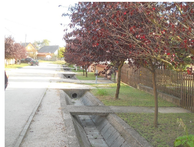
53. fotó: Burkolt vízelvezető árok Keszölcön
