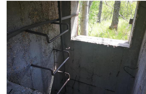
26. fotó: Bunker belseje a Pilis-tetőn (Fotó: Huszko Dorottya)
